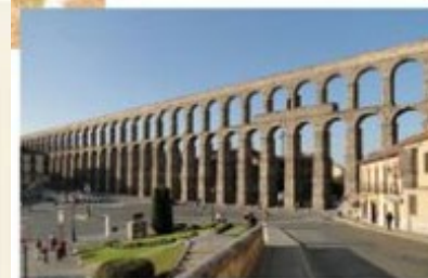
3 Het aquaduct van Segovia: het grootste Romeinse bouwwerk in Spanje. Het werd gebouwd door keizer Trajanus (1ste eeuw na Chr.) en bracht water van 17 km ver naar de stad.
