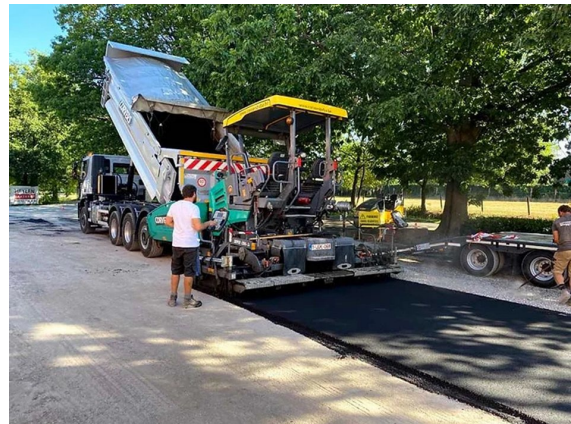
4 - Asfaltspreidmachine gevuld door vrachtwagen
