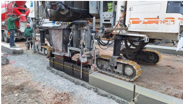
7 - Glijbekisting: kantstrook van de weg
