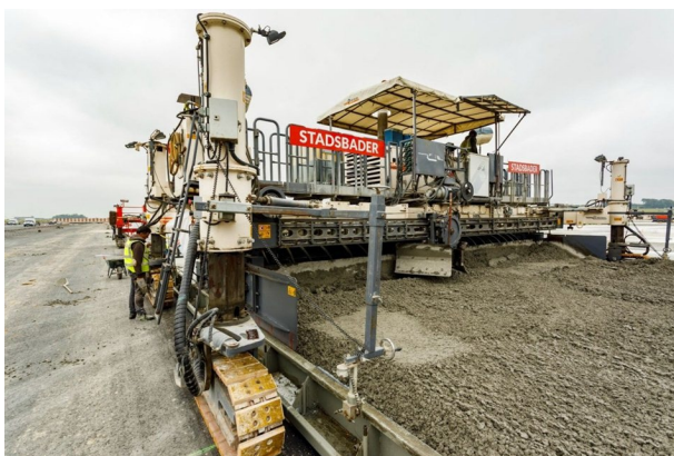
9 - Glijbekisting: aanbouw van een betonnen weg
